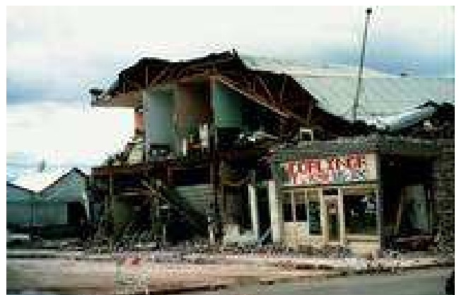
La escuela elemental de Government hill "desgarrada" por la subsidencia producida durante el sismo de 1964. Obsérvese la enorme grieta en primer plano, causada también por el sismo que alcanzó una magnitud 9,2. Tomado de The American Geological Institute Earth Science world Image Bank at: http://www.earthscienceworld.org/images/ Photo ID: hfyysg. Courtesy United States Geological Survey.
