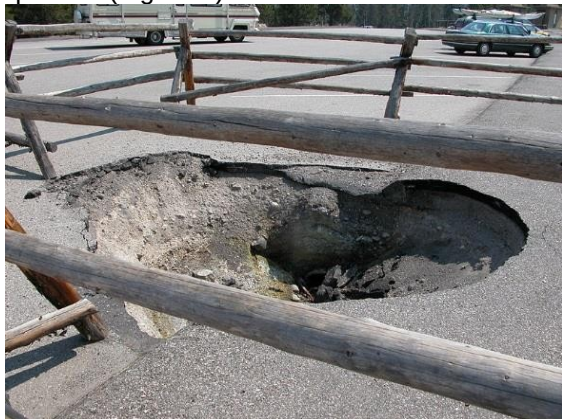
Figura 5. Voragine in un parcheggio del Parco Nazionale di Yellowstone (Foto: Ildar Sagdejev, Wikimedia Commons CC BY-NC-SA)
