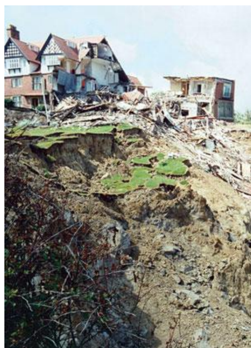
El colapso del Holbeck Hall Hotel, Scarborough, Yorkshire, el 1993. (BGS foto ID 10741/1).
