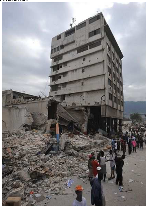
Edifici danneggiati nel quartiere Bel-Air di Port-au-Prince dopo il terremoto di Haiti del 2010. Il palazzo più alto rimane in piedi tra le rovine di edifici più bassi, costruiti meno bene.
